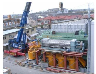
写真1 スクリュープレス設置状況
