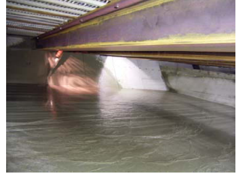
写真-1 流動化処理土打設状況
