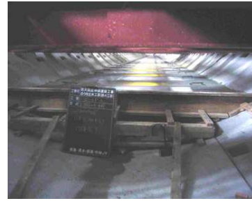
写真-2 インバート打設状況
