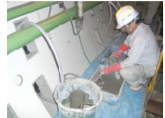
写真 - 2 PCグラウト施工状況
