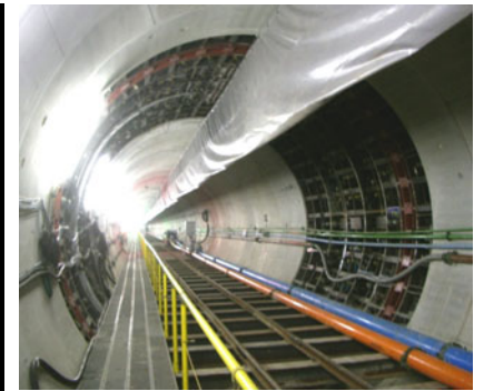
写真－3 拡幅完了後全景 （スチールセグメント9リングのうち、 中央3リングを拡幅）
