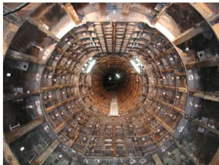
写真-1 小口径実証施工 (拡幅後断面)
