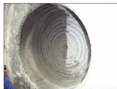
写真-3 切削跡 (先行ビット, タイプB)
