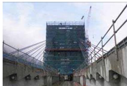
図-3 P2 一次斜材(10 段/10 段施工完了)
