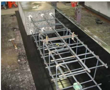
写真-1 新設スラブ側の鉄筋組立て状況
