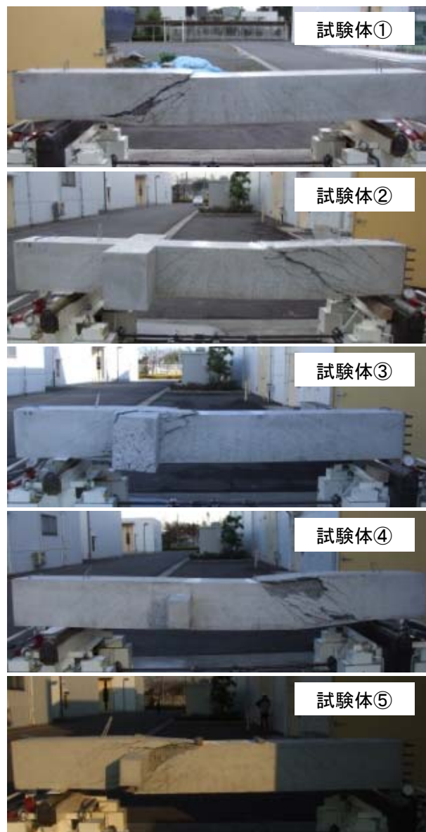
写真-1 試験終了後の各試験体の様子
