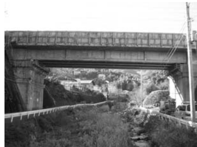
写真-1 白糸川橋りょう外観
