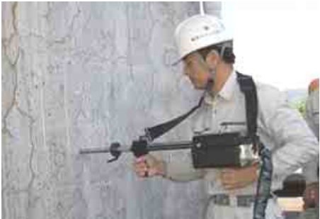
写真-1 調査状況
