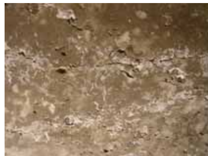
写真-4 骨材のポップアウト
