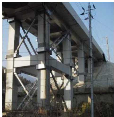
写真-2 施工完了後の状況
