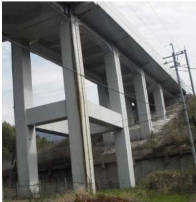
写真－1 高架橋全景
