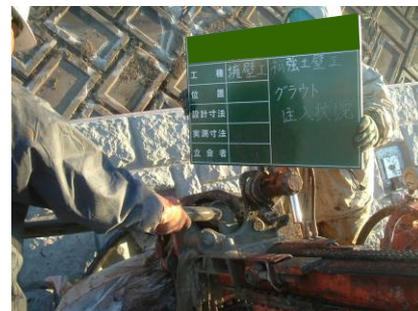
写真-5 補強体への注入状況
