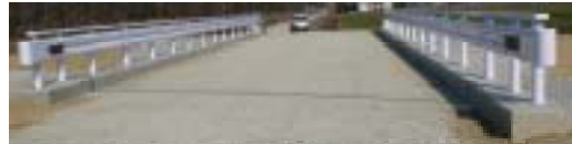
写真3 道路橋の床版と地覆の施工例(冬期3月施工)
