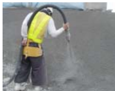
写真 - 1 吹付けの施工状況
