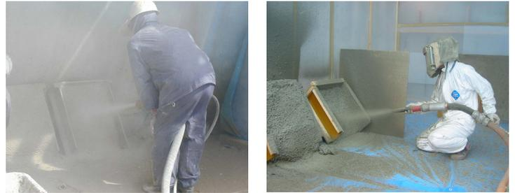
写真1—従来の乾式吹付け状況 写真2—本研究の吹付け状況
