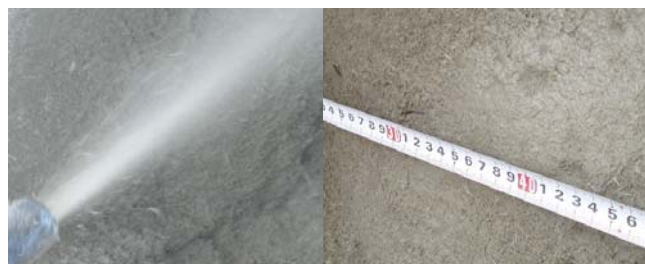
写真-1 吹付け(左)および吹付面の状況(右)
