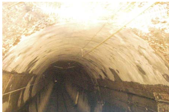
写真-3 ネット併用吹付けモルタル施工箇所(アーチ部)
