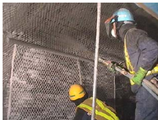
写真-1 ネット併用吹付けモルタル施工状況
