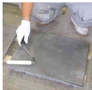
写真-1 試験体製作状況(PIC板)
