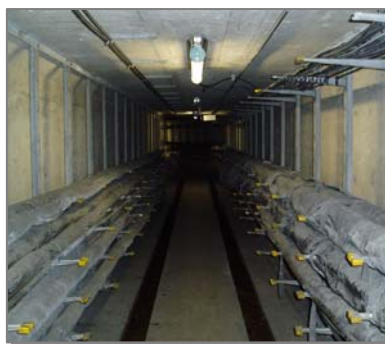
写真-1 開削とう道の全景
