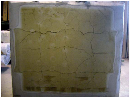
図-5 耐火試験後の状況
