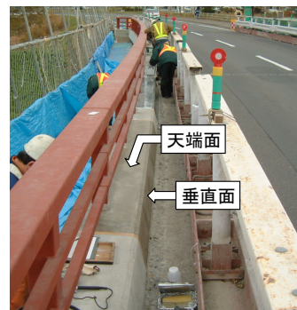
写真-1 試験施工(A橋)
