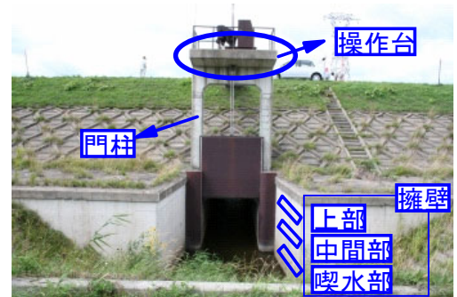
図-4 調査部位（河川樋門）
