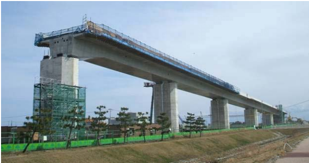
写真-2 上部工完成状況
