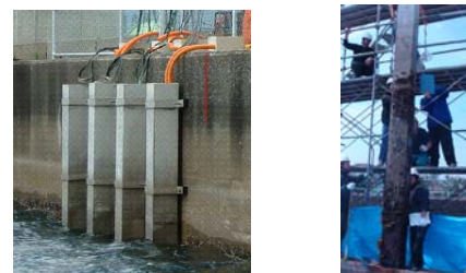
写真-1 供試体設置および引上げ状況
