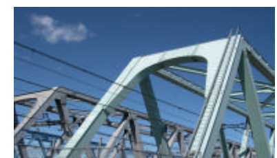
写真-5 A橋りょうの状況 3
