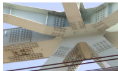
写真-4 A橋りょうの状況 2
