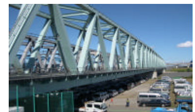
写真-3 A橋りょうの状況 1
