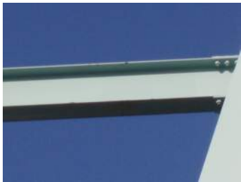
写真-2 N橋りょうの状況
