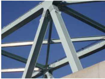
写真-3 N橋りょうの状況
