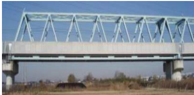
写真-1 N橋りょうの状況
