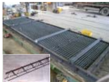
図-3 ラチストラス筋と鉄筋籠
