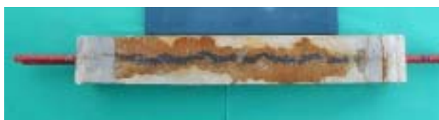
写真-1 電食終了後の鉄筋コンクリート試験体
