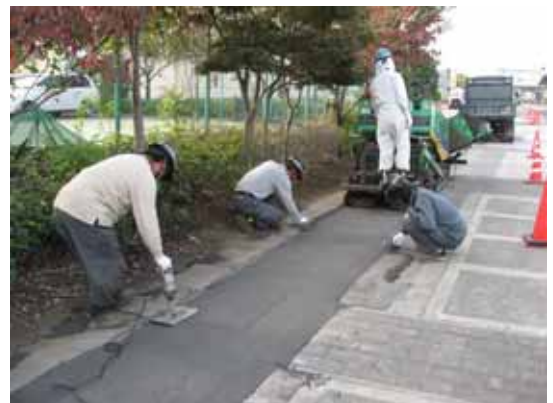
写真-1 施工状況
