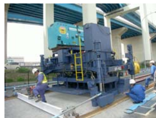
写真 1 大型フィニッシャー
