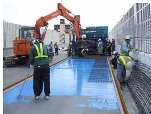
写真2 接着剤と炭素繊維製格子筋
