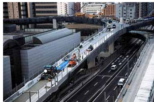
写真1 S F R C 舗装施工状況
