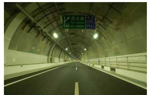
写真3 粗粒度ギャップアスファルト舗装完成状況
