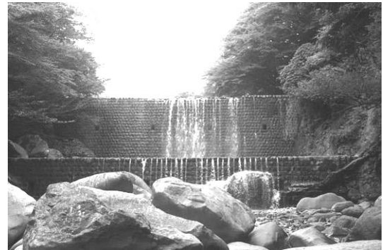
図-7 荒川第6堰堤下流面
