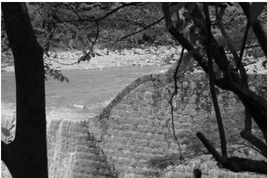
図-2 曲線が入った川上第1堰堤の袖部
