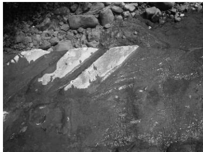
図-3 荒川第5堰堤の水通し縁石
