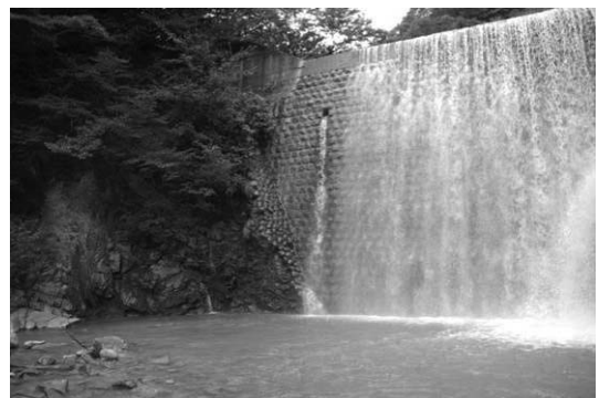
図-8 荒川第3堰堤下流面
