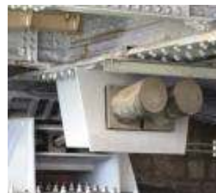
写真—2. 永代橋 落橋防止装置
