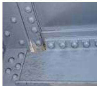
写真—1. 永代橋 高力ボルト
