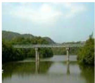
写真—5. 塩屋橋 全景 5)
