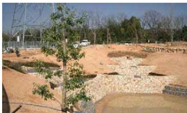
図-7 自然石の落差堰によるろ過池
