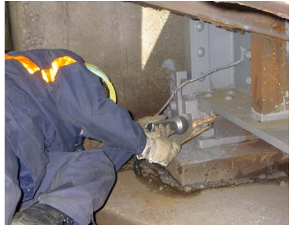
写真-1 鉄けたの目視検査状況
