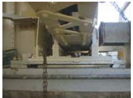
写真-3 改良後の支承
