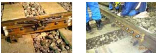
図3 ハックボルト詳細【レール外側・内側】
