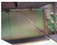
図 1 亀裂発生箇所 (H16年3月)
