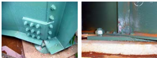
写真 6 a 当板補強と b 再溶接
