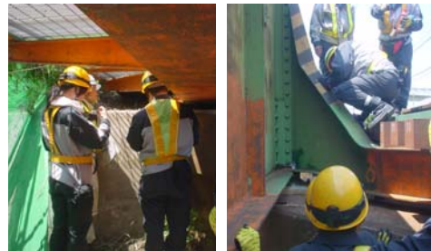
写真 4 塗装足場を利用した検査
