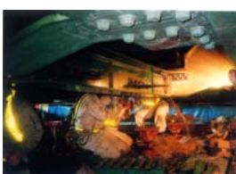
写真 3 当板補強および縦桁交換
