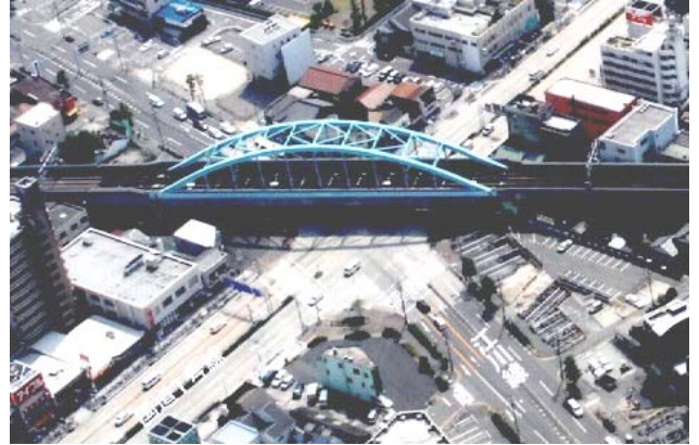
写真-1 第2六番町架道橋
