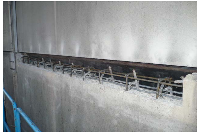
写真-1 変状部除去後鉄筋組み直し(線路内より)
