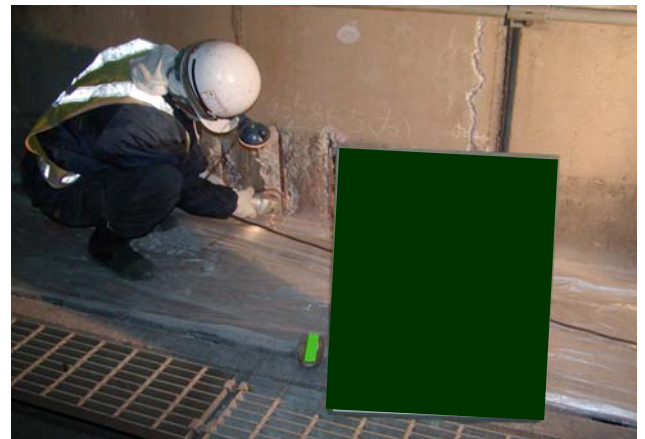
写真-2 鉄筋部錆除去(線路内)
