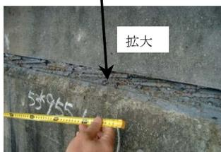
写真-2 RC天端部の変状
