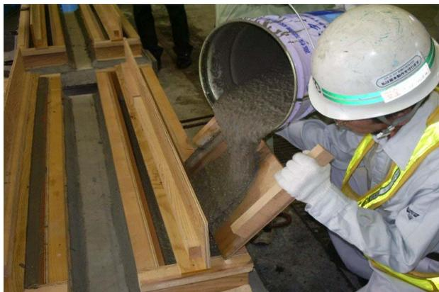
写真-3 モルタル流し込み(MF550+骨材)
