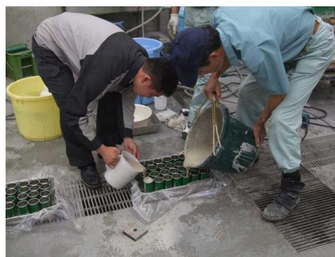
写真-2 モールド充填状況
