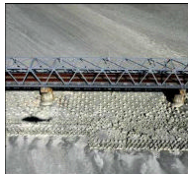
図-1 富士川橋りょうと根固め工
