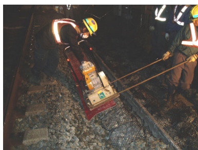
図5 施工性試験(傾斜敷設での転圧, 補強鉄筋打込み)
