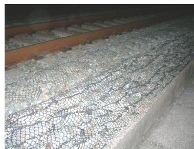
図6 敷設状況(鉄筋打ち込み前・後)
