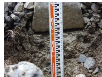
図5. マクラギ端の排水状態
