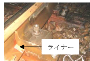
写真1 ライナー取付状態
