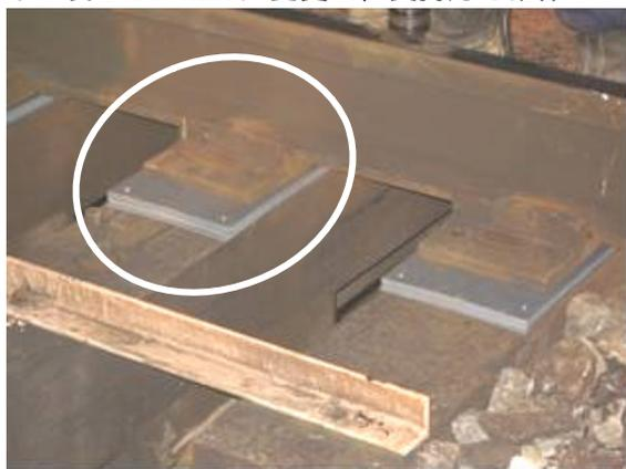
図5 樹脂製パッキン材 (施工中)
