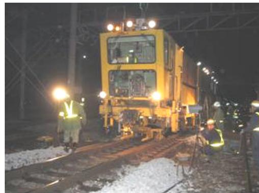
図6 SW-MTTによる施工
